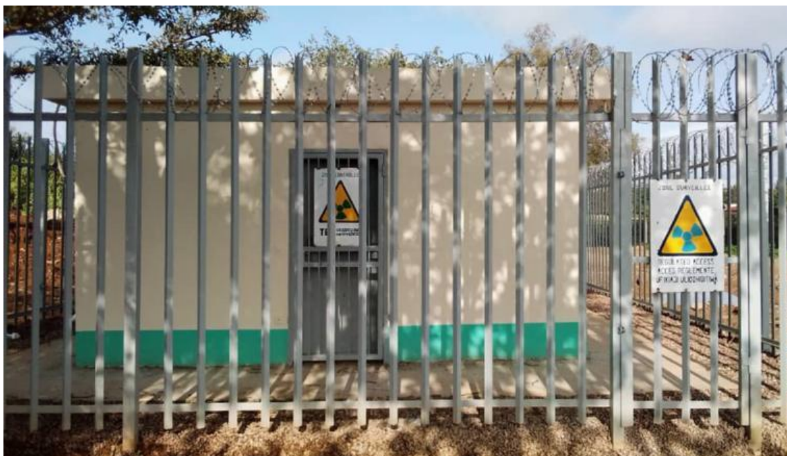
Figure 55. Fin des travaux de construction du Bunker pour les radioéléments
