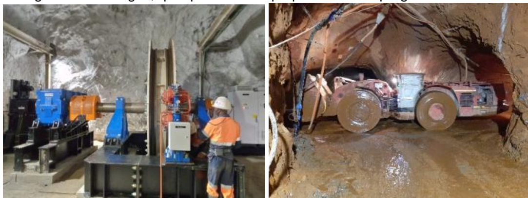
Réhabilitation de la machine du Puits 2 bis niveau 450 m Dénoyage et nettoyage du front de l'incline au niveau 1327m
