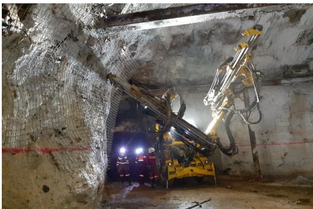
Figure 39. Travaux de soutènement du garage des engins au Niveau 1132 m
