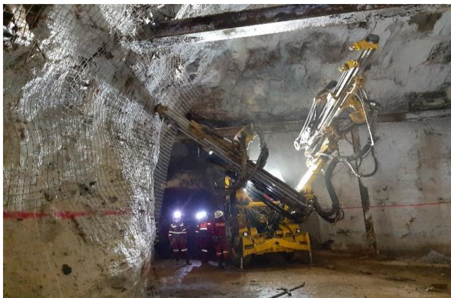
Figure 38. Travaux de soutènement en cours de réalisation
