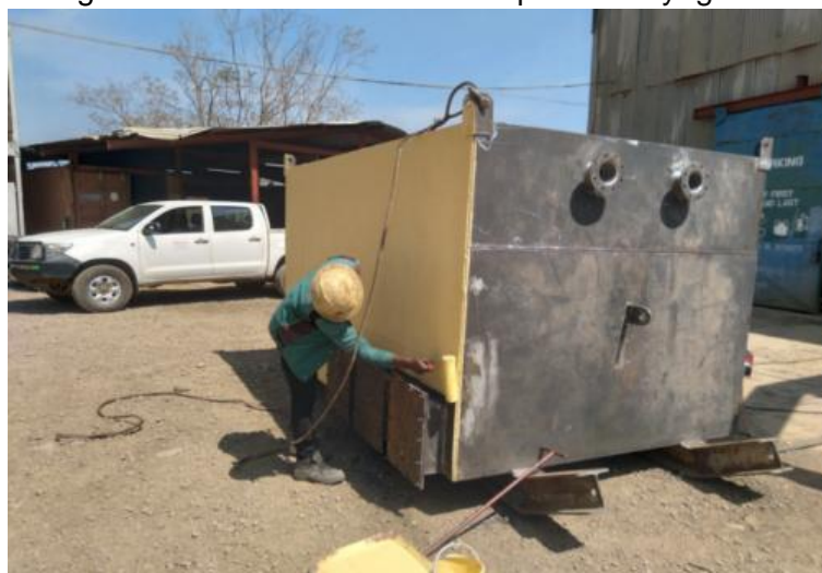
Figure 14. Fabrication des tanks pour dénoyage.
