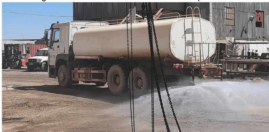
Figure 60. Arrosage du site afin de réduire les effets de la poussière en saison sèche
