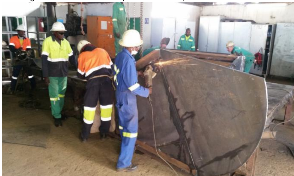
Figure 5. Fabrication de la porte radiale du puits à minerais en cours
