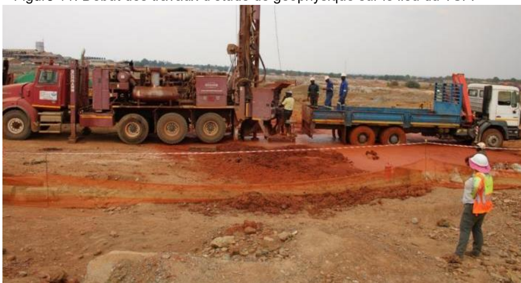
Figure 11. Début des travaux d'étude de géophysique sur le lieu du TSF.
