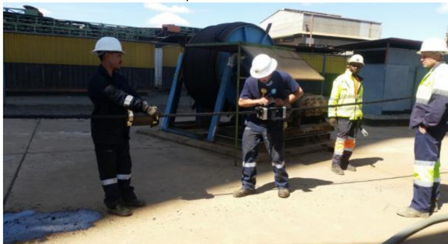
Figure 6. Techniciens de TND&TEM en plein test au P 5 du câble de réserve du P 9 ter.
