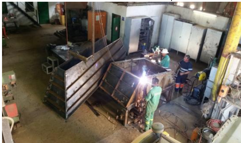
Figure 7. Fabrication d'une nouvelle chute a minerais pour la bande T5 du Puits 5.
