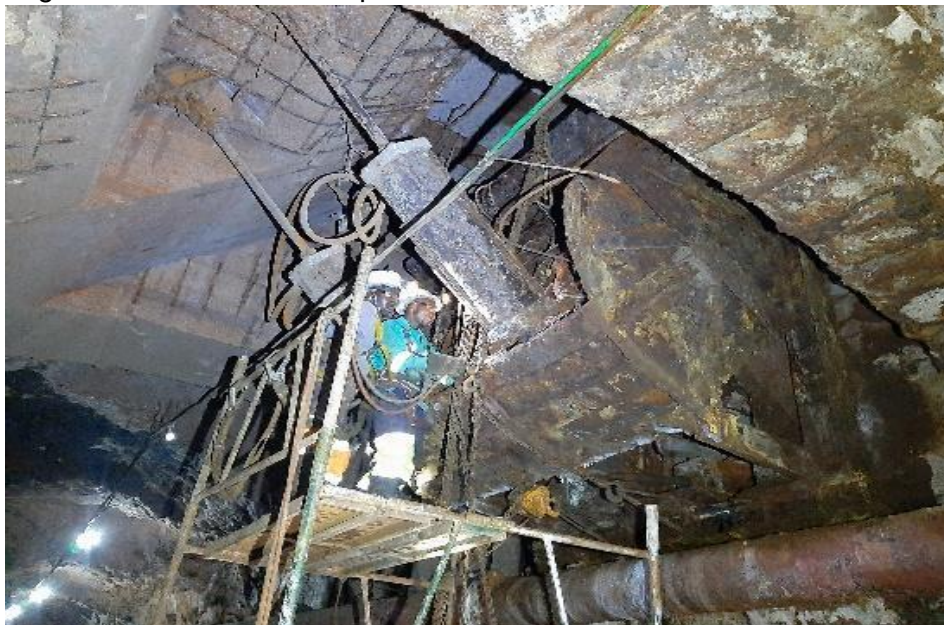
Figure 2. Entretien du casque de déversement des minerais au Puits 21
