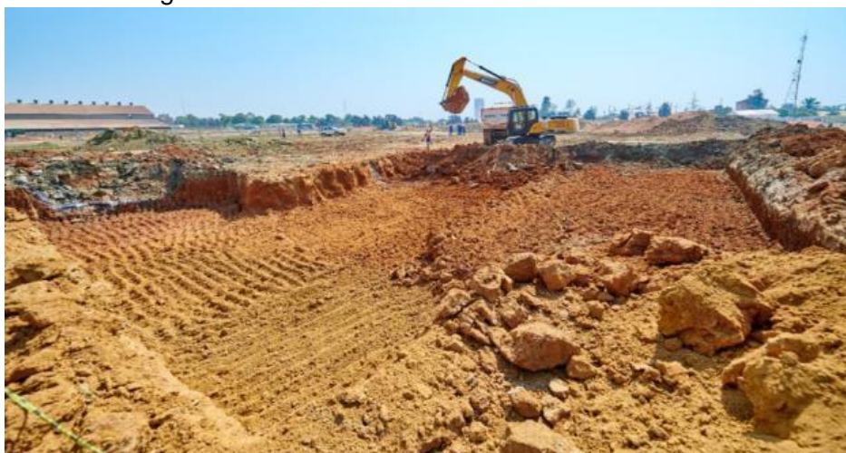
Figure 10. Travaux excavation de la sous-Station
