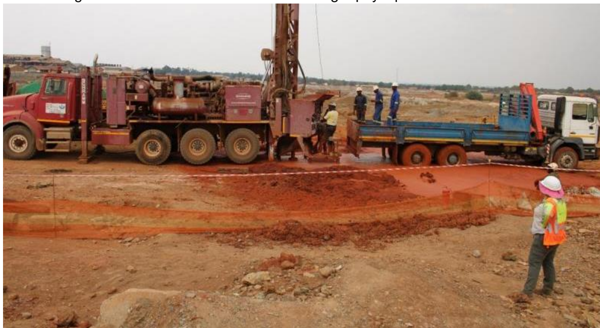
Figure 42. Début des travaux d'étude de géophysique sur le lieu du TSF.
