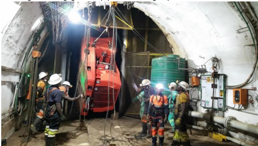
Figure 1. Elingage des équipements et engins pour le Niveau 1150 m.
