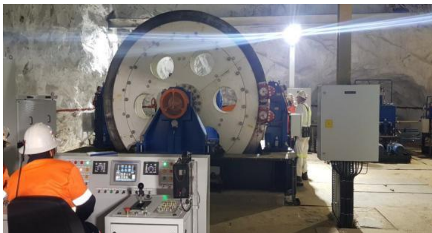
Figure 15. Mise en service en toute sécurité de la machine du Puits 2bis.
