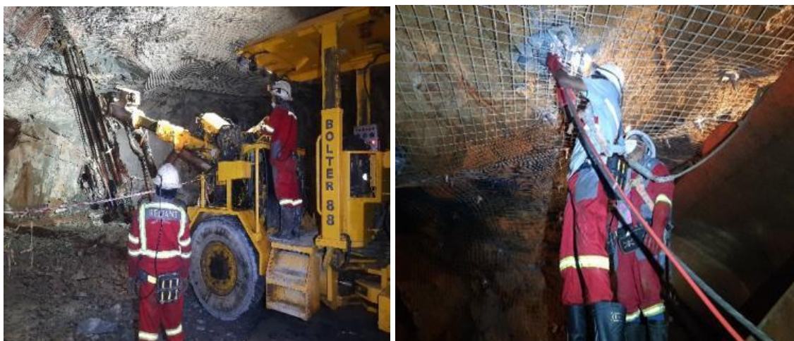
Figure 41 : Travaux de soutènement au niveau 1327 et de la progression de l'incliné.
