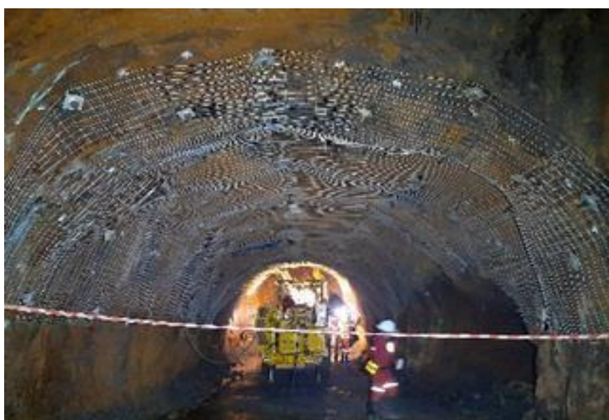
Figure 38. Travaux de soutènement en cours de réalisation
