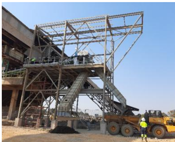
Evacuation du foudroyage par le convoyeur T5
