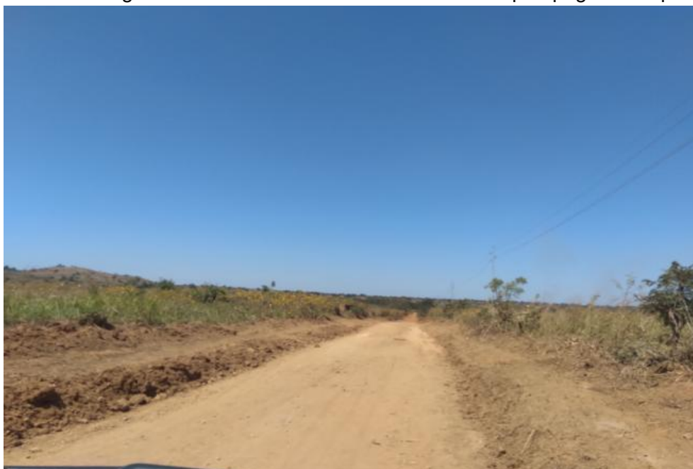
Figure 12. Aménagement de la route d'accès a la station de pompage d'eau potable
