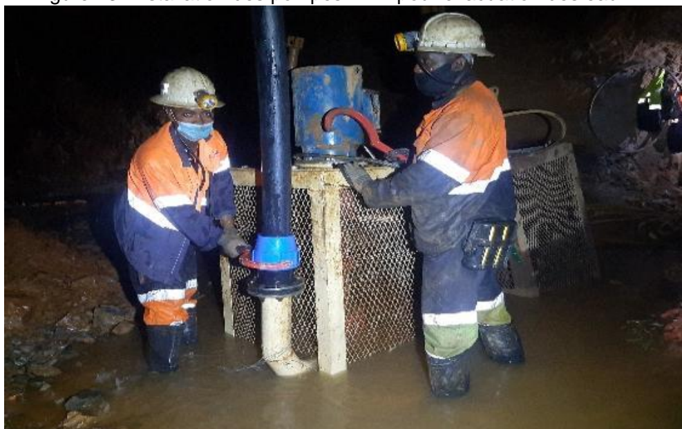
Figure 13. Installation des pompes RNE pour évacuation des eaux
